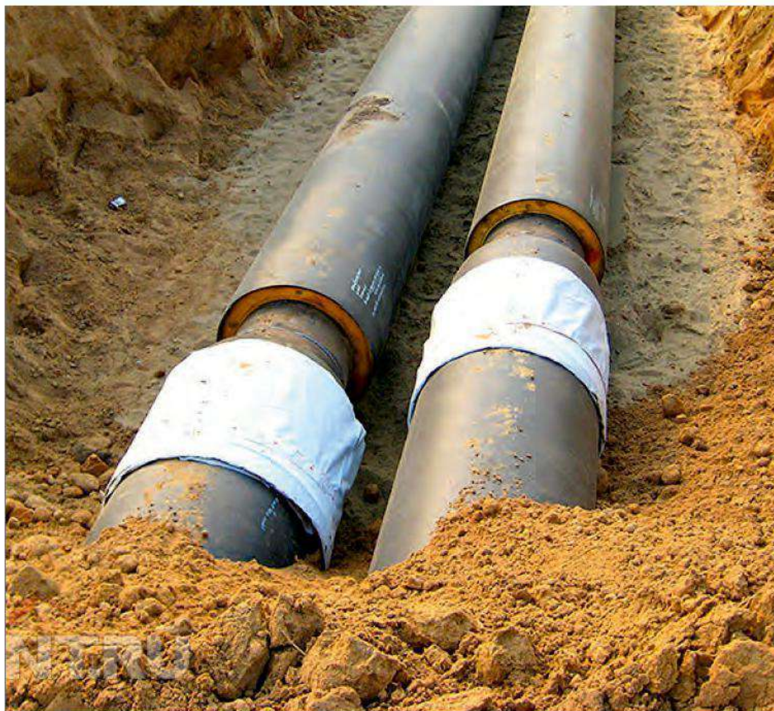
Водо- и теплопроводные сети
