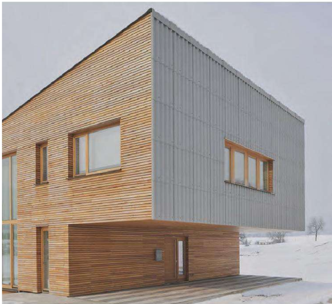
Наружная облицовка стен
